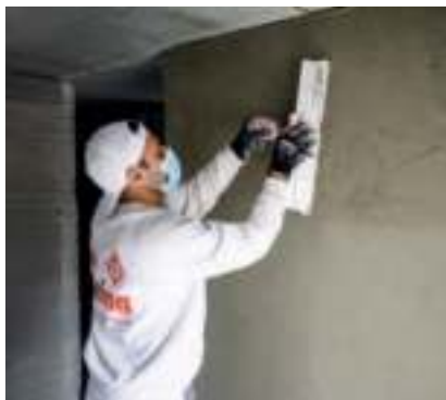
Perfekte Wandbehandlung mit der Kartätsche nach dem Putzauftrag. Foto: Lukas Schulze/akurit
