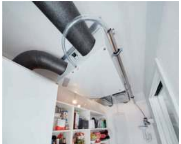
Das Lüftungsgerät Zehnder ComfoAir 160 verfügt über besonders platzsparende Außenmaße. Mit einer kompakten Größe von gerade einmal 670 x 268 x 770 Millimeter findet das Gerät selbst in engster Wohnumgebung seinen Platz – so wie in der Wohnung von Frau Rubin in der Speisekammer.
