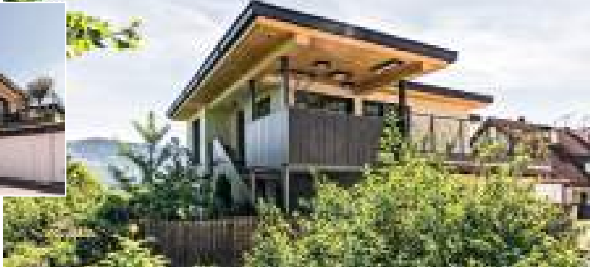
Aufgrund des relativ geringen Gewichts des nachhaltigen Baumaterials Holz wird das bestehende Gebäude auch bei größtmöglicher Ausnutzung der Kubatur geringstmöglich belastet.
