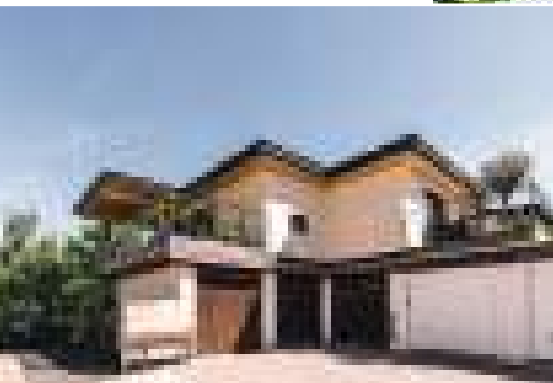
Aufgrund des relativ geringen Gewichts des nachhaltigen Baumaterials Holz wird das bestehende Gebäude auch bei größtmöglicher Ausnutzung der Kubatur geringstmöglich belastet.
