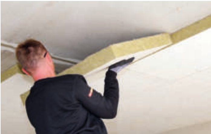
Positionieren der Dämmplatten.
