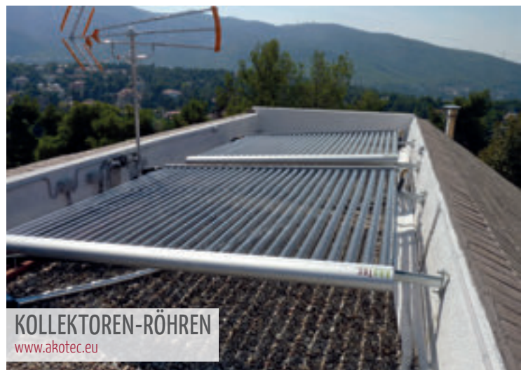
Platzsparende AKOTEC Vollvakuum-Röhrenkollektoren können sehr flexibel angebracht werden
