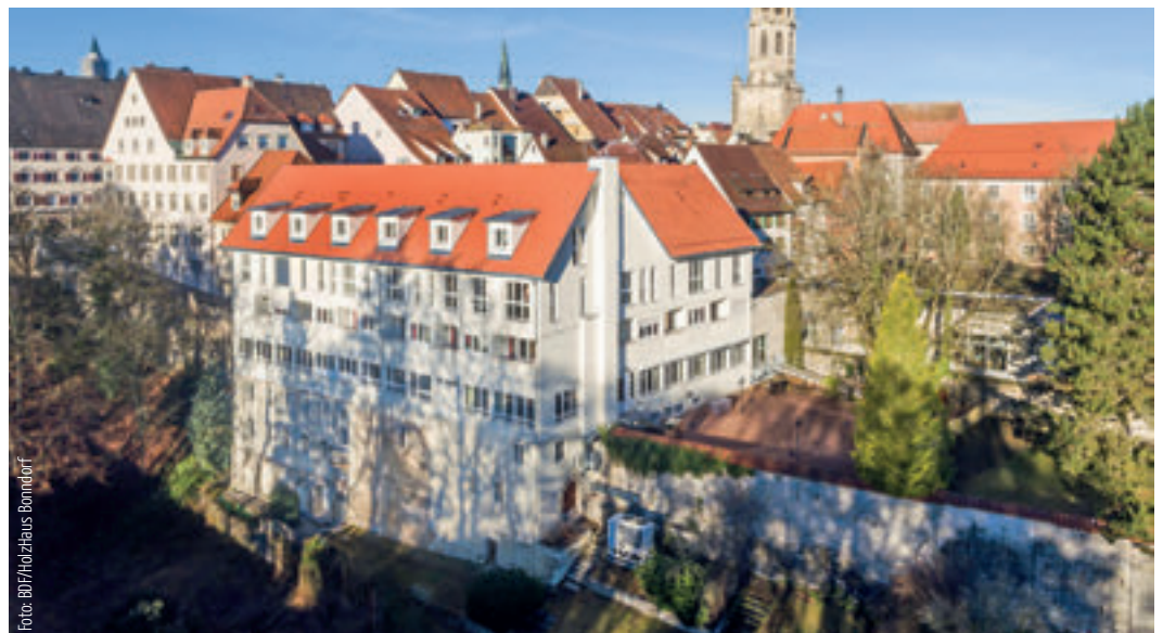
Die Aufstockung von Bestandsgebäuden im urbanen Raum ist mit seriell produzierten Holz-Fertigteilen sehr gut möglich
