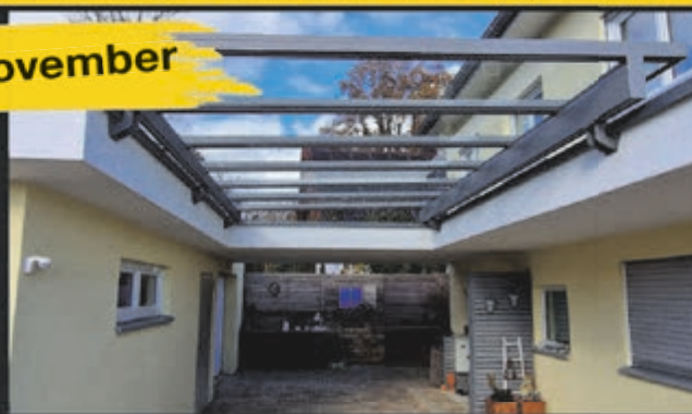
Überdachung in Reinstetten
