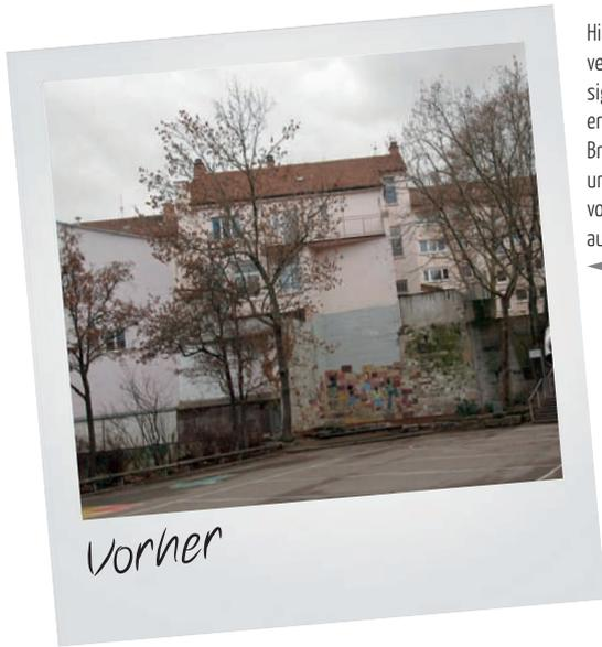
Hier der in einem Innenhof verborgene zweigeschossige Backsteinbau bevor er mit konfigurierbaren Brettsperrholz Dach- und Deckenelementen von Lignotrend aufgestockt wurde.
