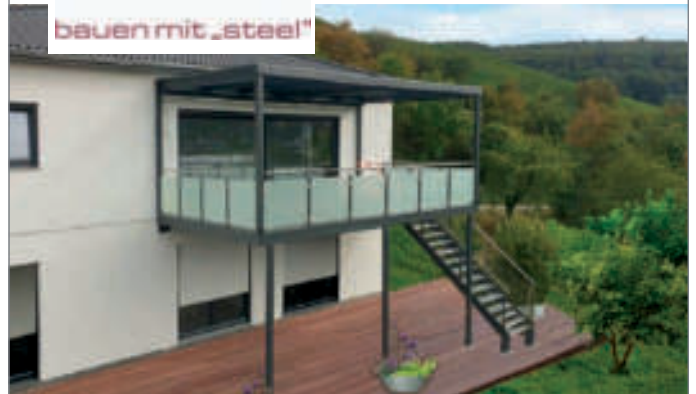
Anbaubalkon mit Überdachung, Beschattung und Treppe
