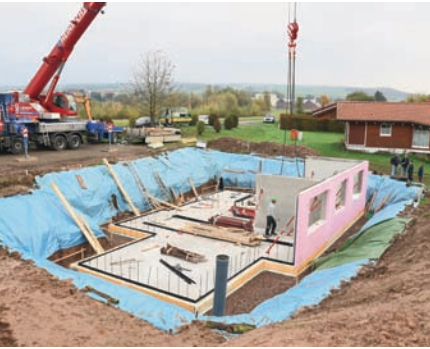
Blick zurück: Das Fundament ist gesetzt.
