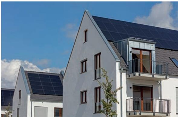
Auf allen Dächern der „Sonnenhäuser“ in Moosburg befinden sich Photovoltaik-Anlagen. Zusammen mit einer zentral installierten Solarthermieanlage und einer Holzschnitzelheizung decken sie einen Großteil des Heizenergie- und Strombedarfs ab.
