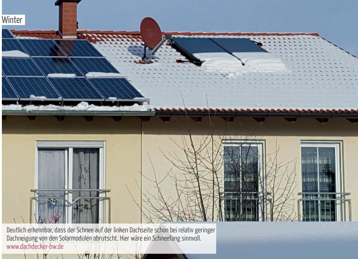
Deutlich erkennbar, dass der Schnee auf der linken Dachseite schon bei relativ geringer Dachneigung von den Solarmodulen abrutscht. Hier wäre ein Schneefang sinnvoll. [www.dachdecker-bw.de](http://www.dachdecker-bw.de)
