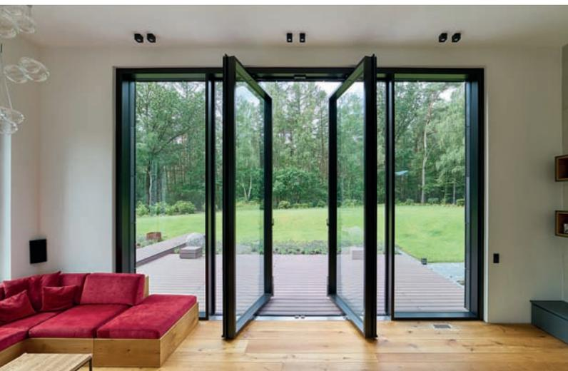
**Spektakuläre Abmessungen:** 6,05 x 4,20 Meter misst das dreifach verglaste Fassadenelement mit einem U-Wert von 1,15 W/m<sup>2</sup>K (Schüco Stahlssysteme Jansen VISS 50).
