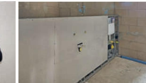
VeroBoard® Rapid ist feuchteunempfindlich. Damit ist die Platte auch ideal für die Montage im Bad. Die Sanitäreinrichtung in Volkesfeld erfolgte als Vorwand-Installation.
