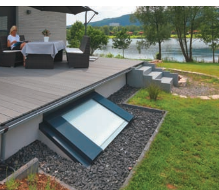
Für den Lichtfluter dachten sich die Bauherren eine sichtgeschützte Abdeckung aus, die sie individuell gestalteten.
