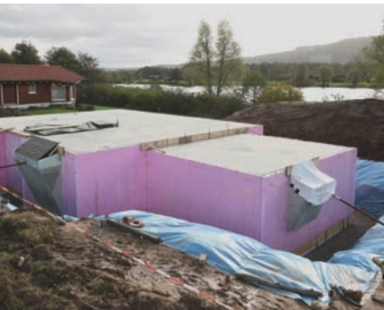
Alles passt: Die ab Werk vorgefertigten Wandelemente werden vom erfahrenen Kellerbauer KNECHT auf der Baustelle montiert und mit Ortbeton fugenlos miteinander verbunden.
