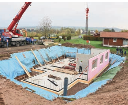
Blick zurück: Das Fundament ist gesetzt.
