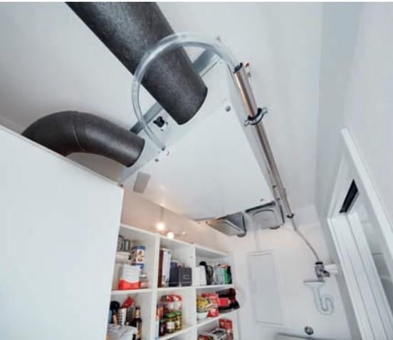
In den Ablufträumen wie der Küche sieht man von der installierten Lüftungstechnik nur einen dezenten, mit einer Edelstahlabdeckung versehenen Abluftauslass unterhalb der Decke.
