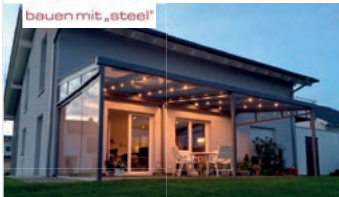
Überdachung/Anbaubalkon mit Schiebelementen/Kaltverglasung
