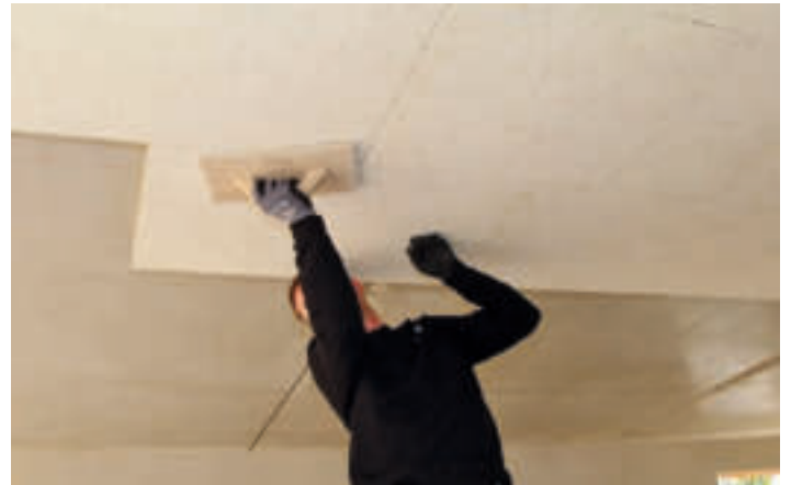
Dämmplatten andrücken.
