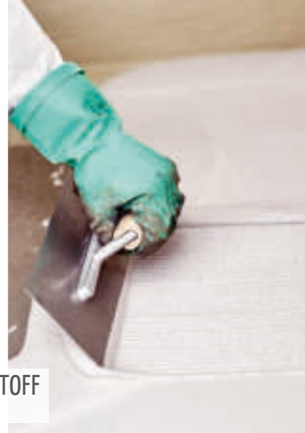
Fachhandwerker können eine Balkonsanierung mit Flüssigkunststoff an nur einem Tag realisieren.
