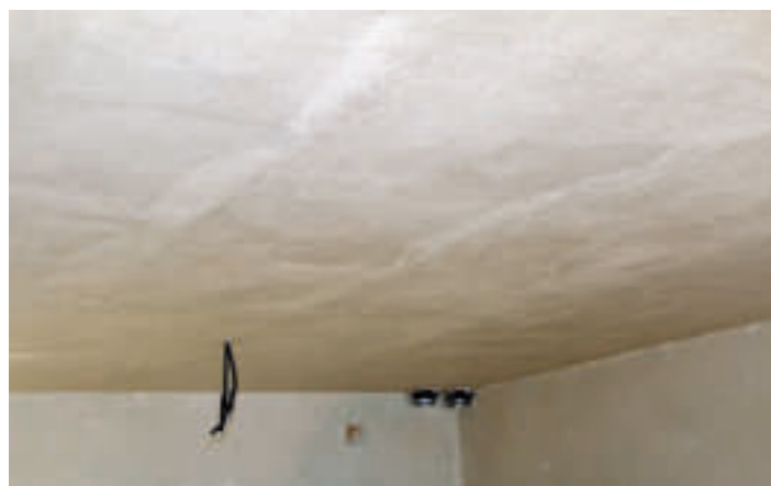
Gegebenenfalls Farbgebung durch Airless-Auftrag oder Armierungsspachtelung mit anschließendem Anstrich.
