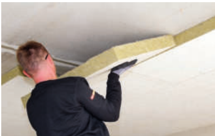
Positionieren der Dämmplatten.
