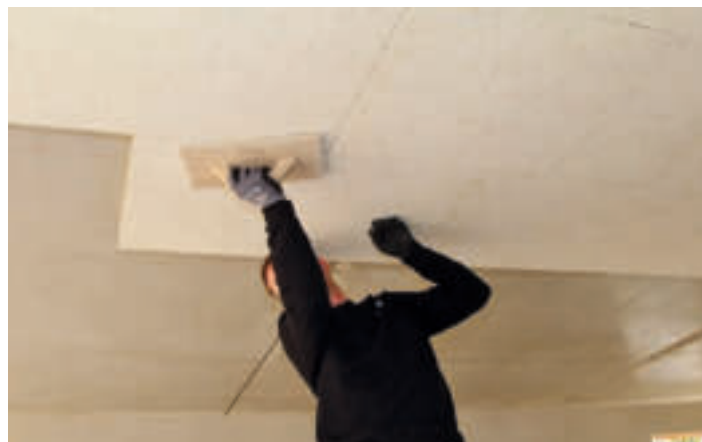
Dämmplatten andrücken.
