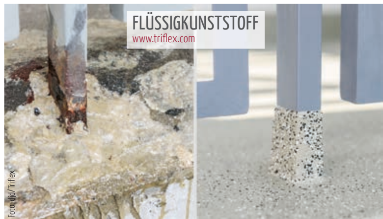
Bei einem nicht akkurat abgedichteten Balkongeländer droht das Eindringen von Feuchtigkeit (links). Mit Flüssigkunststoff lassen sich Details und Übergänge unterschiedlicher Materialien langzeitsicher abdichten (rechts).
