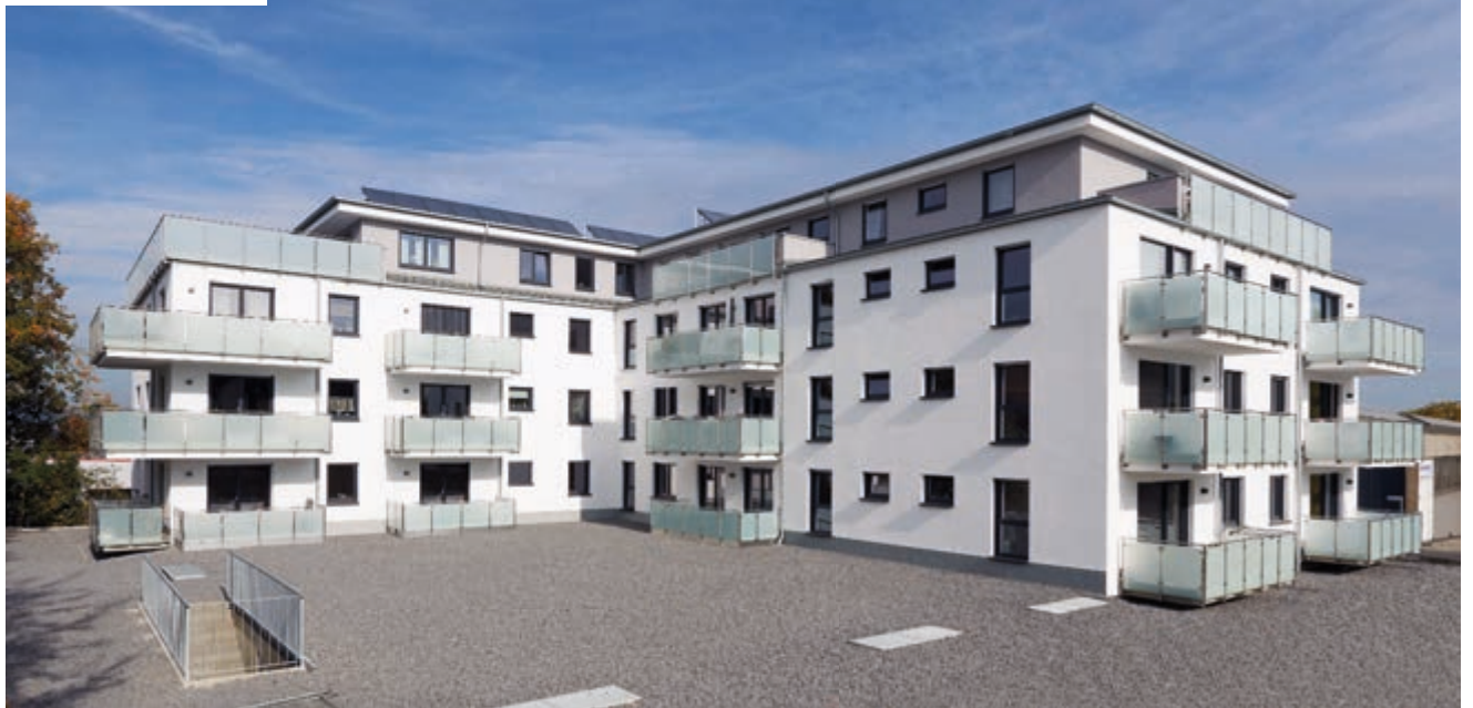
Serielle Vorfertigung für notwendigen Wohnungsbau: Das neue Wandtafel-System „KLB-RATIOWALL“ ermöglicht die schnelle und sichere Errichtung mehrgeschossiger Wohngebäude.
