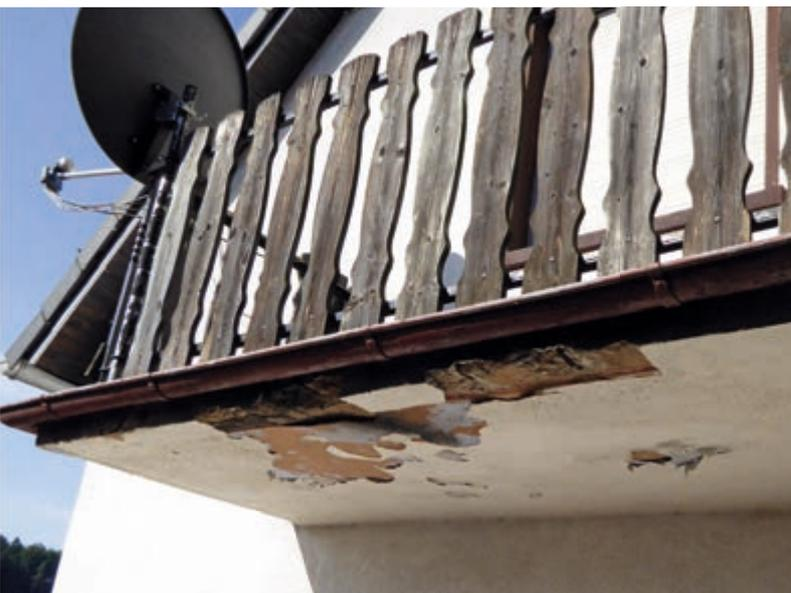
Sind feuchte Stellen oder Abplatzungen an der Unterseite des Balkons zu entdecken, sollten Fachleute zur Prüfung hinzugezogen werden.
