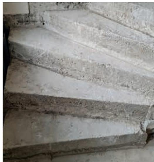
„Charme“ der 60er: Auf der Treppe waren, um die glatten, kalten Stufen des rosafarbenen Marmors sicherer zu machen, orientalisches anmutende Teppichfliesen aufgeklebt. Zunächst blieben von der Treppe die nackten Betonstufen, die der Erstbesitzer selbst gegossen hatte. Sie waren schief und verschieden hoch.
