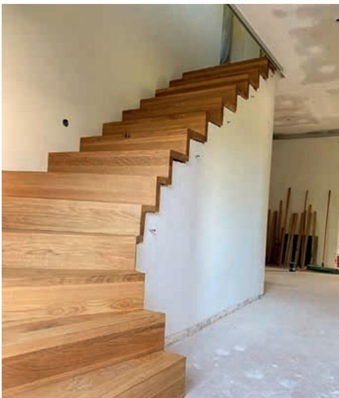
Die Stufenbeläge aus geölter Eiche in 4 cm Stärke wurden in Schreinerarbeit gefertigt.
