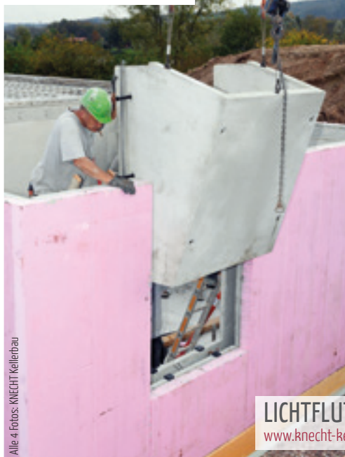
Präzisionsarbeit: Der Original Lichtfluter wird von KNECHT Kellerbau im Werk vorgefertigt und auf der Baustelle exakt eingesetzt.
