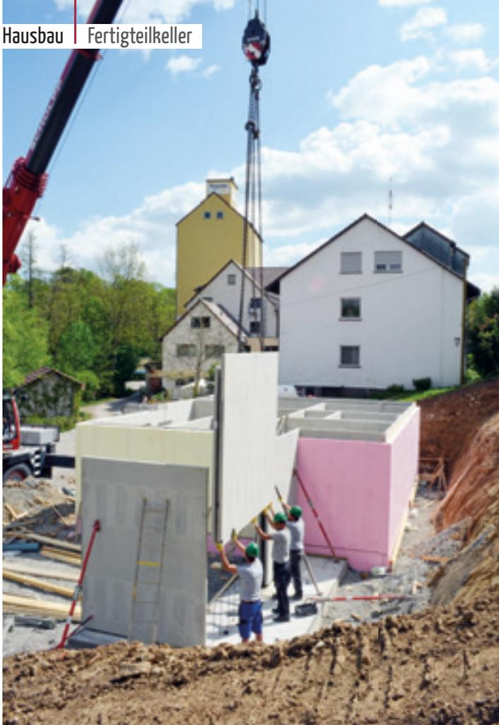
Die Fertigelemente des Kellers wurden im Werk vorproduziert und auf der Baustelle in kurzer Zeit montiert – ein stabiles Fundament für das Einfamilienhaus.
