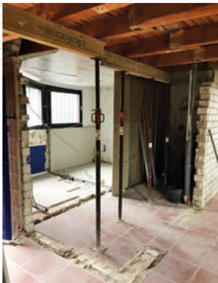
Der Bungalow während des Umbaus.
