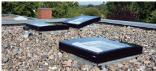
Gebogenes Flachdach-Fenster Konvex-Glas von Velux sorgt für einfaches Abfließen von Regenwasser. Durch nur leicht gebogenes Glas integrieren sie sich harmonischer in die Dachfläche als herkömmliche Lichtkuppeln.
