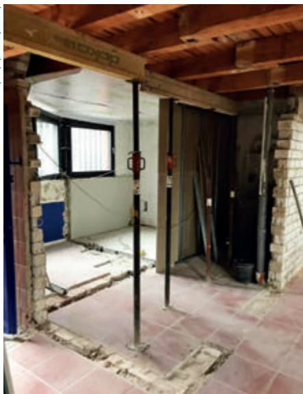
Der Bungalow während des Umbaus.
