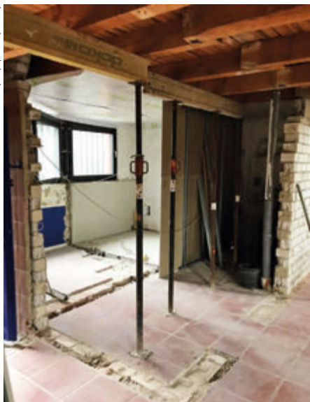
Der Bungalow während des Umbaus.
