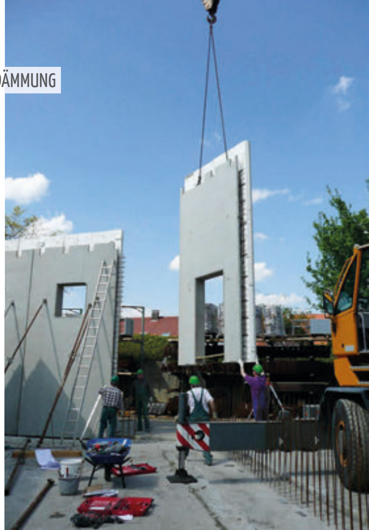
Die Kerndämmung kommt ohne Außenputz aus.
