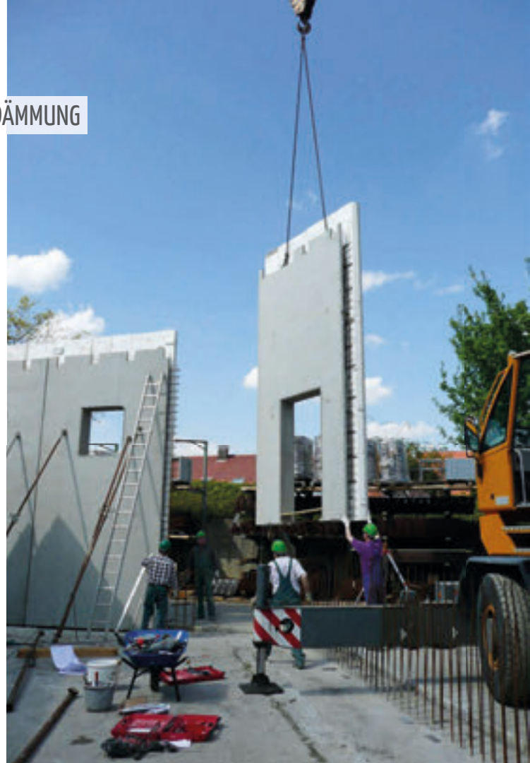
Die Kerndämmung kommt ohne Außenputz aus.
