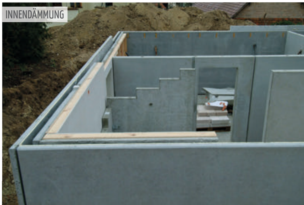
Die Innendämmung empfiehlt sich bei einem nachträglichen Ausbau des Kellers oder bei einzeln beheizten Kellerräumen.
