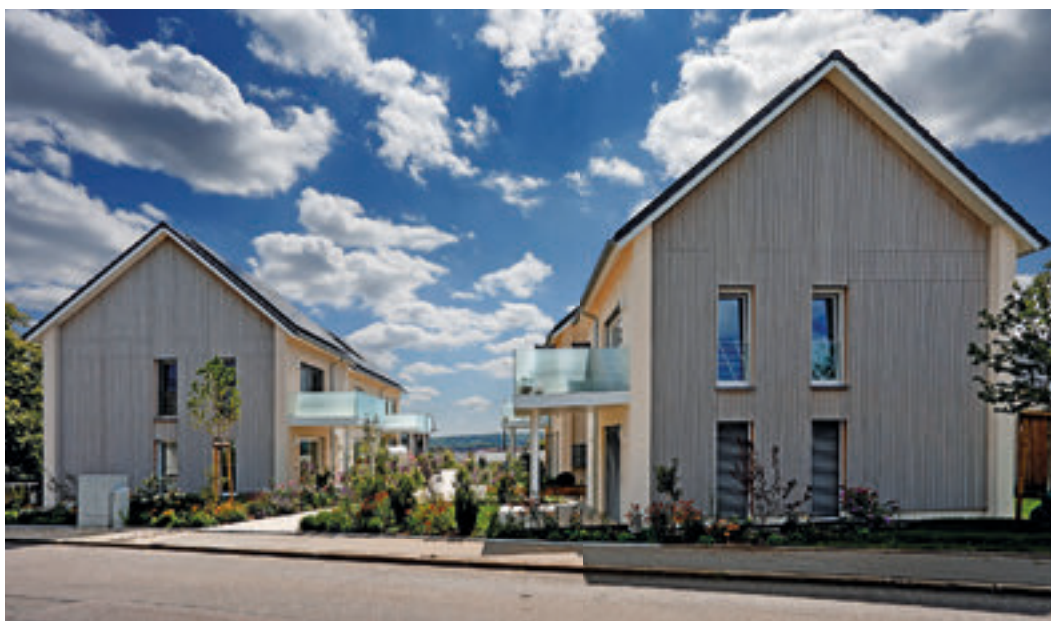
Großzügige Balkone, hochwertige Fensterflächen und abgestimmte Fassadendetails prägen das neue Wohnbau-Ensemble in Westerheim.
